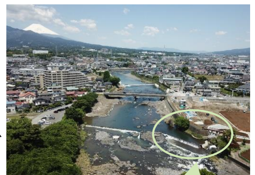
黄瀬川から取水する新井堰の全景 写真提供：長泉町
