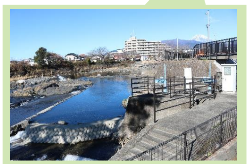
本宿用水の取水口（新井堰）
