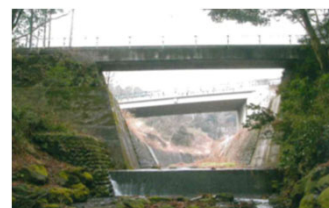
大久保沢「掛樋」 (手前の橋)
