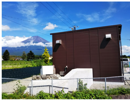
大久保沢埋樋上流の小水力発電所
