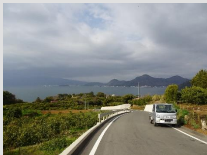
基盤整備後の道路の様子（令和7年3月時点） 車がラクラクすれ違える！道幅は5.5m。
