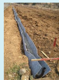
▲暗渠排水工事の様子
