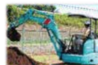
小型車両系 建設機械
