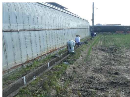
補修中の水路
