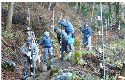
【電気柵設置状況】
