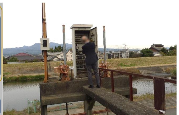
現地調査の様子（群馬県前橋市）
