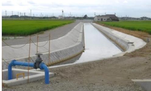
西清水川排水路（栃木南部地区）
