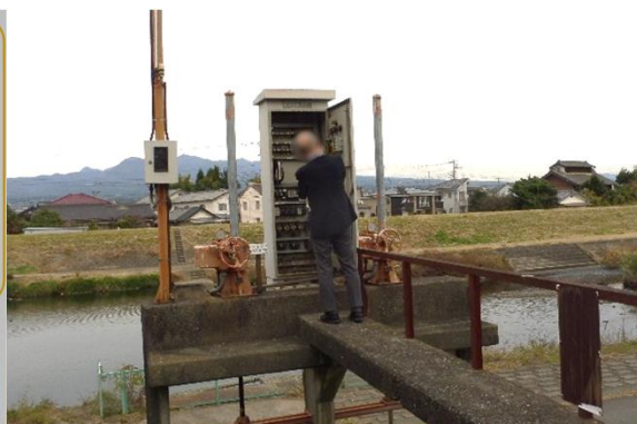
現地調査の様子（群馬県前橋市）
