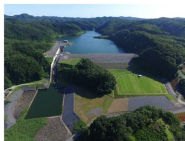
図：御前山ダム（下流側から撮影）
