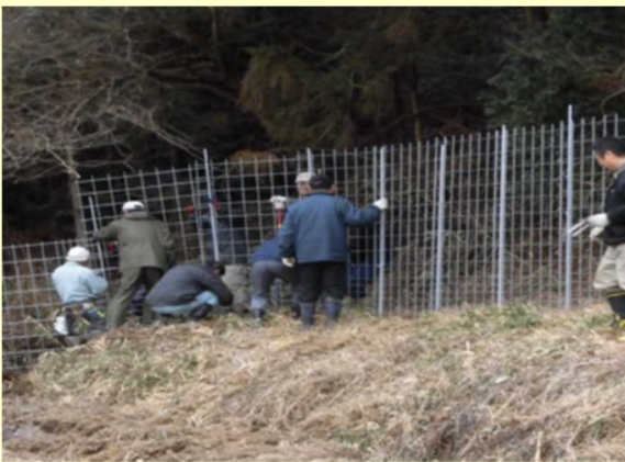
侵入防止柵の設置
