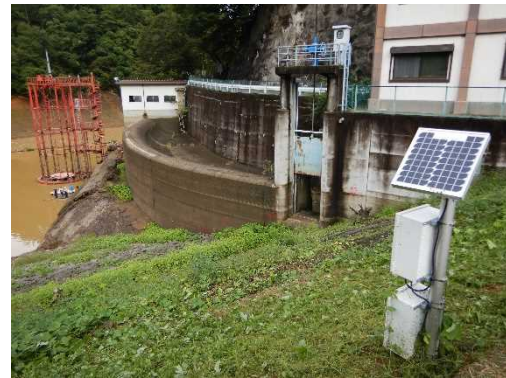
カメラと水位計を設置し、遠方で監視
