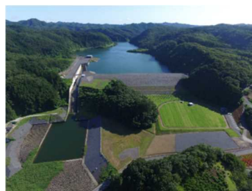
図：御前山ダム（下流側から撮影）
