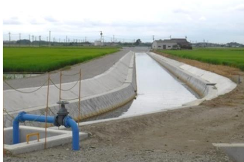
西清水川排水路（栃木南部地区）
