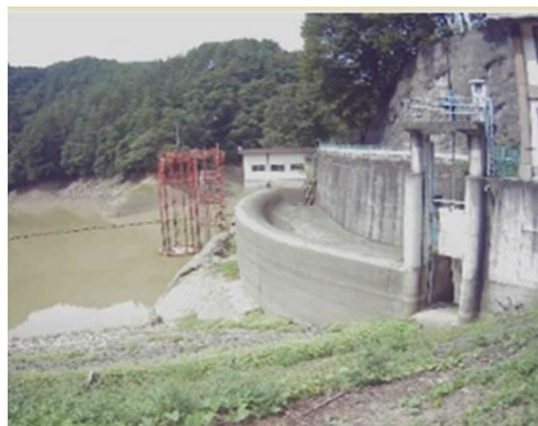
利水として必要のない期間は、落水により低水位を保ち空き容量を確保（長野県上田市沢山池）
