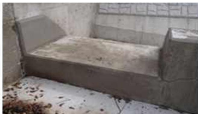
受益面積の減少に合わせて、平時から水位を下げておくためのスリットを設置（長野県長野市浅川池）
