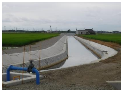
西清水川排水路（栃木南部地区）
