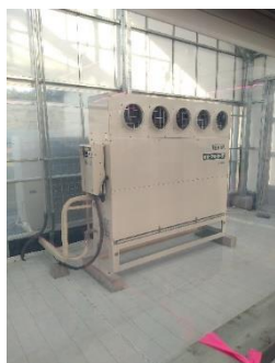
写真（左）：オール電化実証のヒートポンプ
