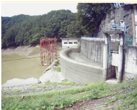
利水として必要のない期間は、落水により低水位を保ち空き容量を確保（長野県上田市沢山池）
