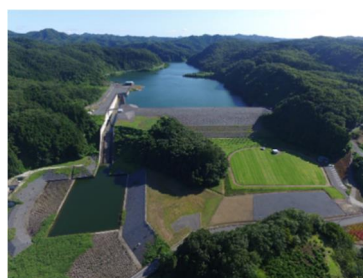
御前山ダム（下流側から撮影）
