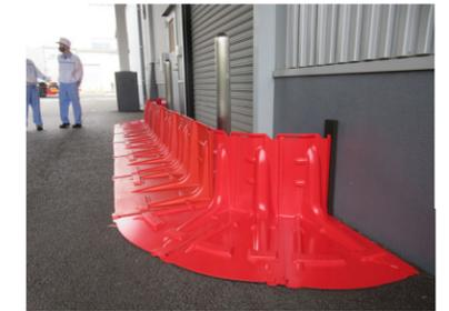
工場の浸水を防ぐ仮設止水板
