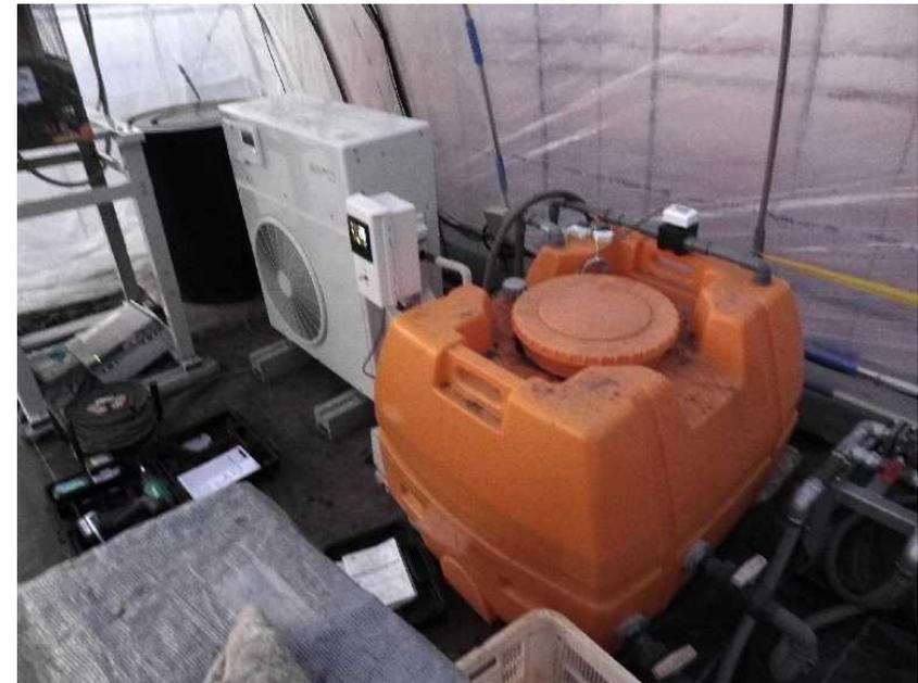
地下水熱源ヒートポンプ（クラウン制御用）
