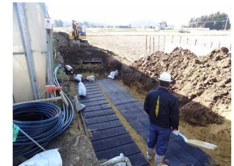
シート型熱交換器設置（深さ1m）
