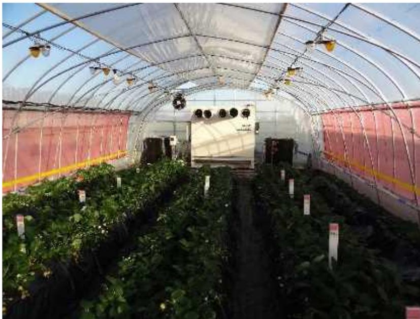
地下水熱源ヒートポンプ（室内制御用）
