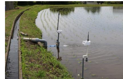
水位センサー（手前）と給水ゲート（奥）
