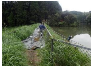
被災箇所の保護
