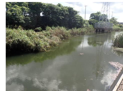
▲除去作業後の排水機場
