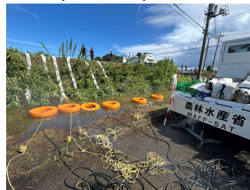
ポンプ(5m 3 /min.)を6台設置
