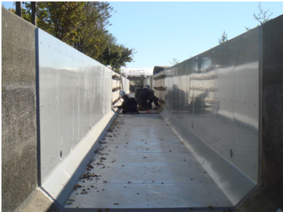
例5) カワヒバリガイの固着を防止する塗料の塗布（手前が塗布前、奥が固着防止剤塗布後）
