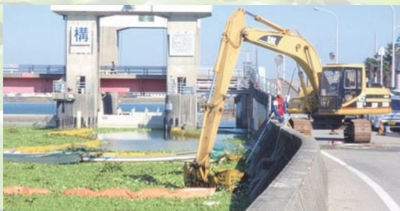
重機（バックホウ）による除去作業の様子
