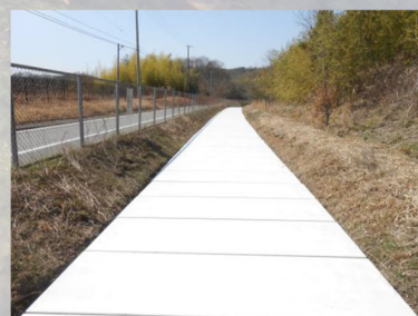
水路の蓋掛けによる遮光
