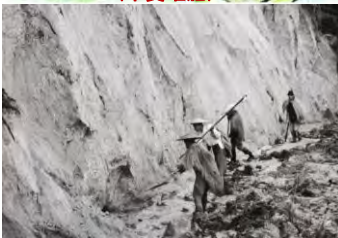
山を切り崩した鉄穴流しの作業
