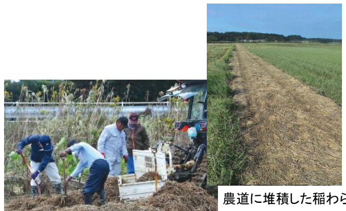
農地に堆積した稲わらの撤去作業
