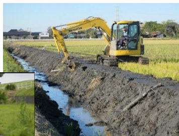
重機を活用した泥上げ
