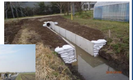
用排水路の補修
