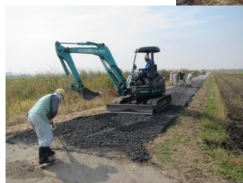
農道の碎石舗装
