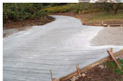
補修後の農道
