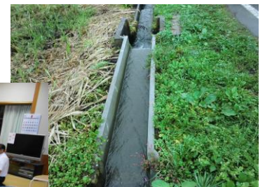
更新した水路
