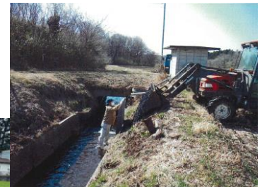
用排水路の補修
