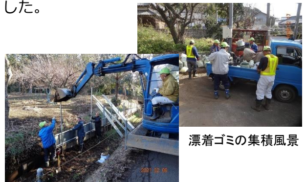
水路の補修風景
