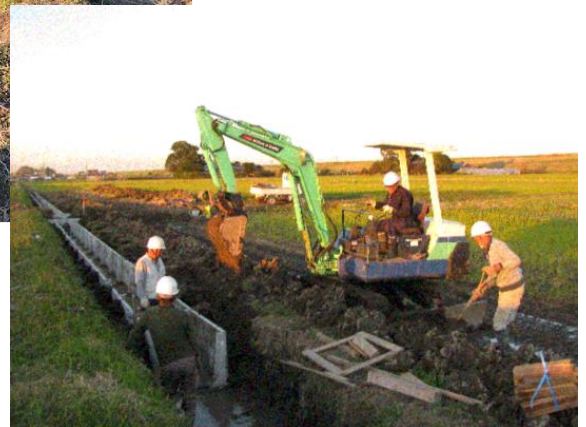
直営施工の様子
