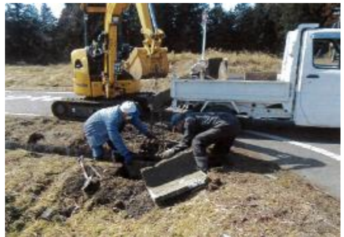
直営による水路補修
