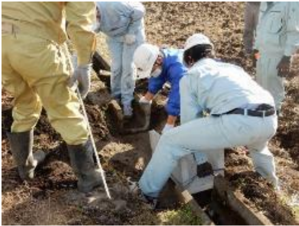
高校生による水路の補修
