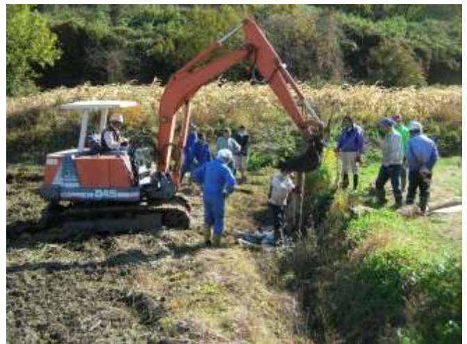
直営による水路補修
