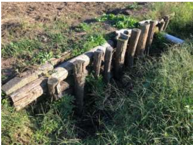
地域にある材料を活かした土留め
