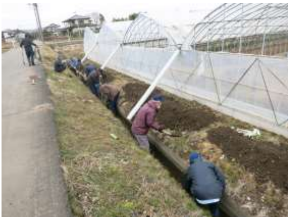
水路の泥上げ作業
