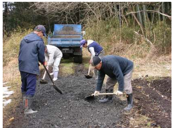
農道補修(砂利敷き)
