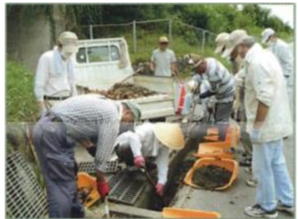
水路の泥上げ作業
