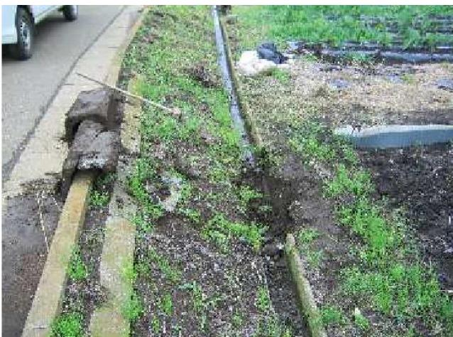
破損したU字溝を確認
