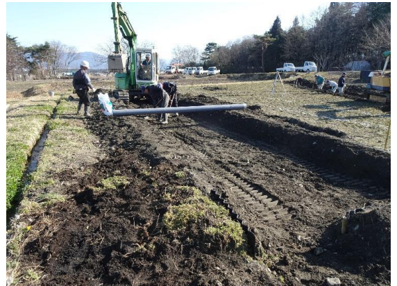
建設中のホタル水路
