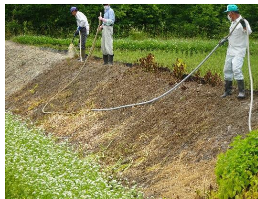
芝の吹き付け作業
