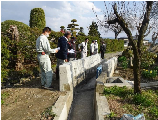
補修した水路
