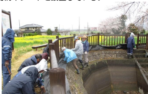
防草シートの設置
