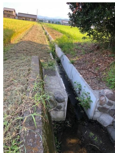
補修した水路
