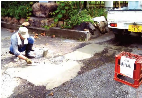
農道の補修作業
