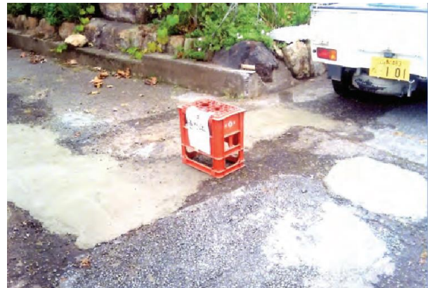
補修後の農道
