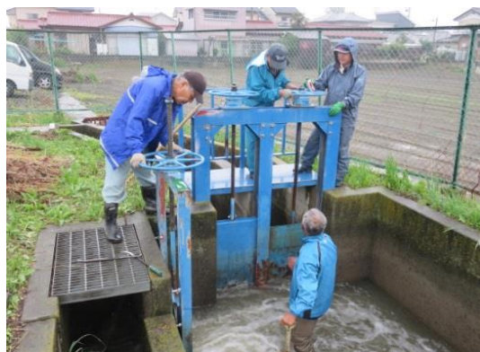
ゲートの点検及び注油
