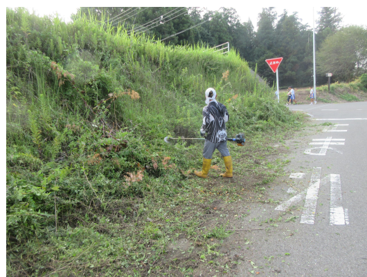
法面補修前の草刈り
