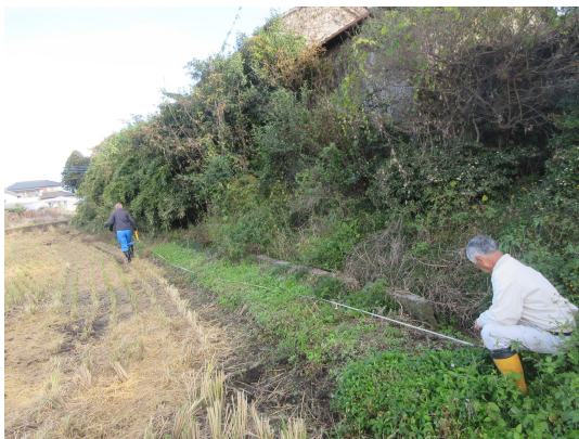
点検・機能診断
