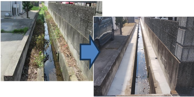
水路敷の防草対策
