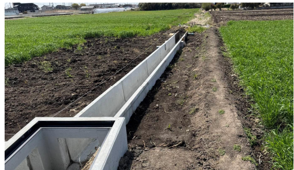
水路を素掘りからコンクリート化
