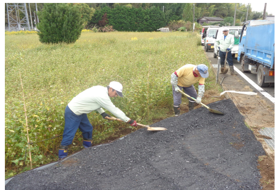
直営施工による農道補修
