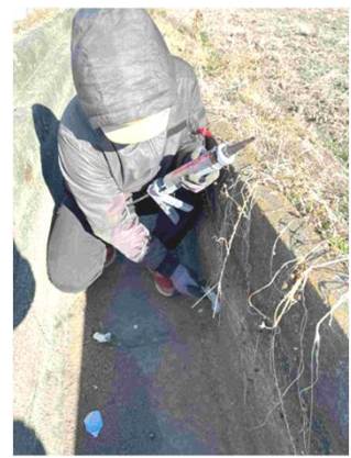
直営施工による水路補修
