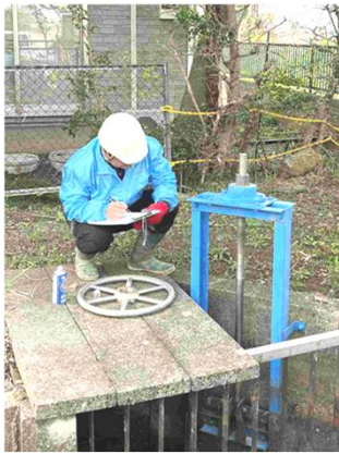
施設機能診断
