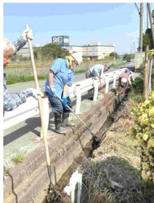
水路清掃作業
