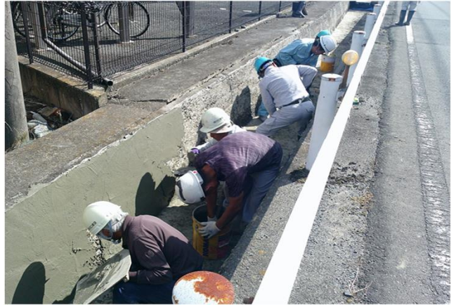
直営施工による水路の長寿命化
