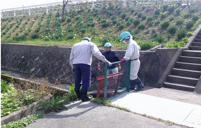
水路の機能診断
