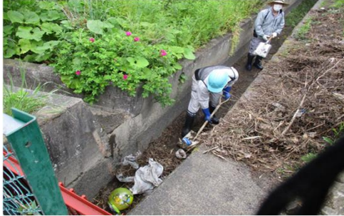
排水路の泥上げ
