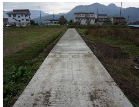
直営施工による農道の舗装
