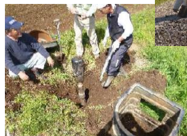
給水栓の補修
