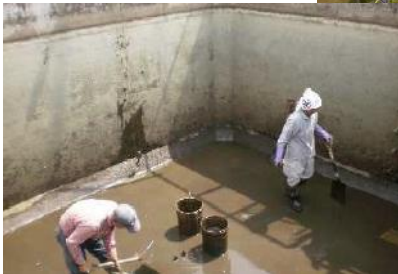
貯水槽の清掃風景
