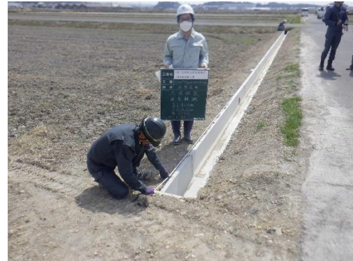
水路の長寿命化
