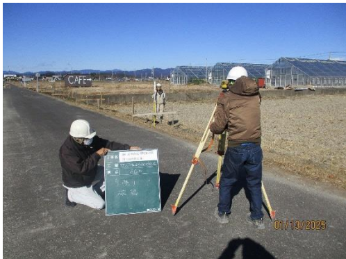
直営による測量
