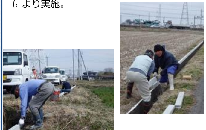
直営施工による水路の嵩上げ
