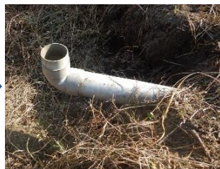
配管を上向きにして雨水を貯留
