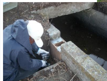
施設の補修風景
