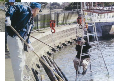
震災の復旧作業
