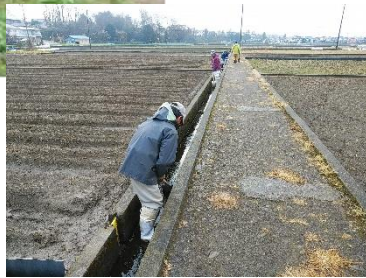
水路の泥上げ
