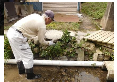
水路の補修風景
