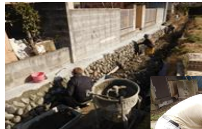
水路の補修風景
